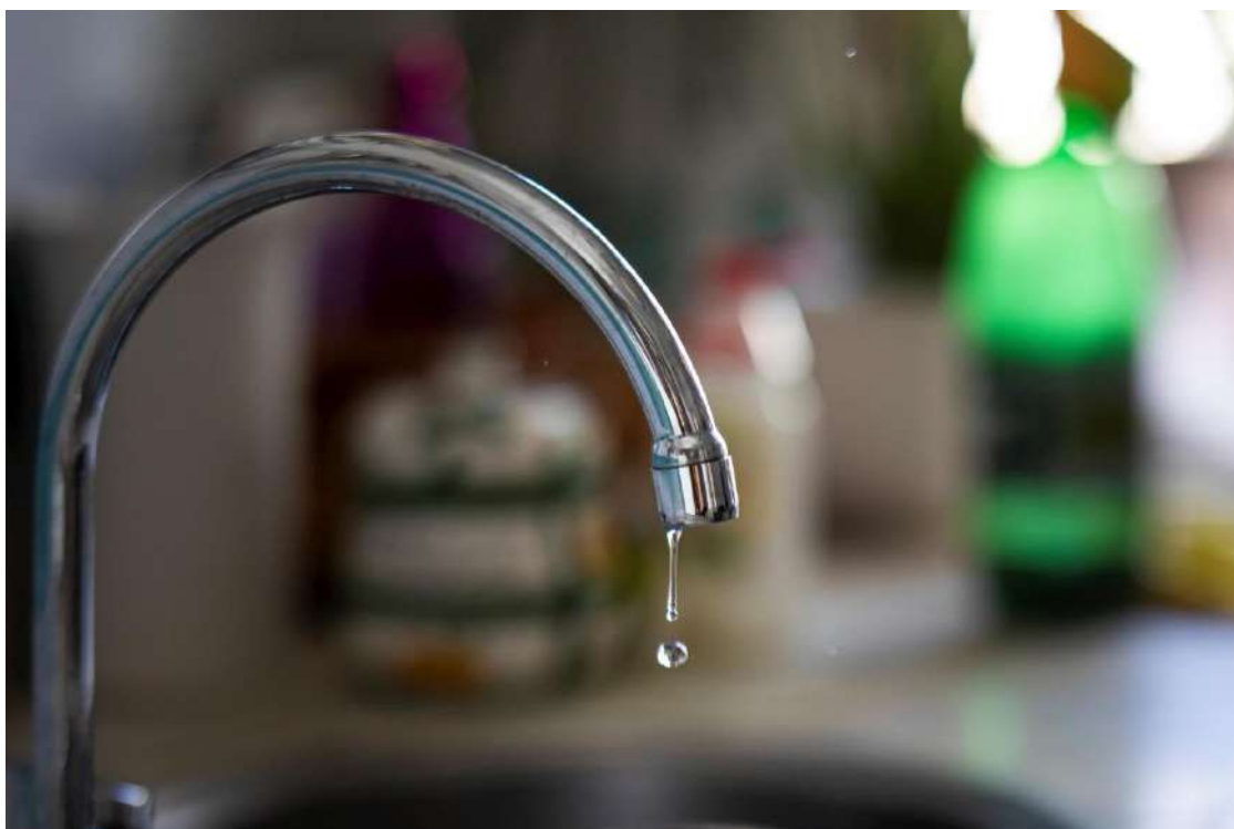
Corte de agua - A.I.
