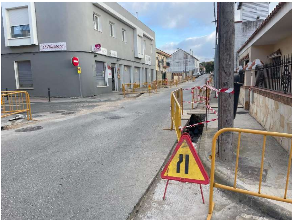
Obras en la avenida Embarcadero, en Algeciras.
