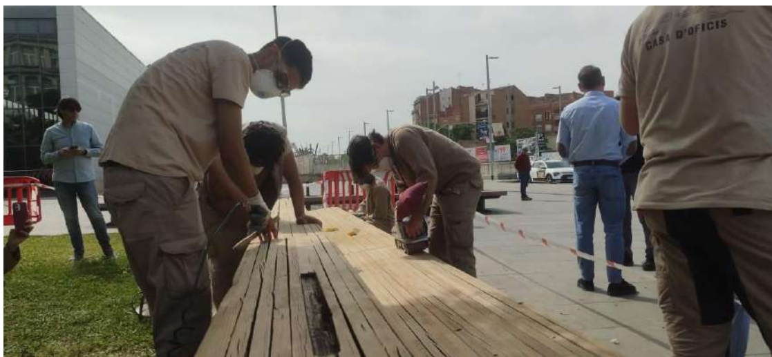
FOTO: D.H. / Operarios del IMO arreglando un banco frente a la estación
