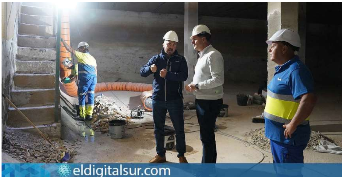
Emilio Navarro visita las obras de mejora e impermeabilización del depósito de abastecimiento de agua potable de San Francisco / EDS
